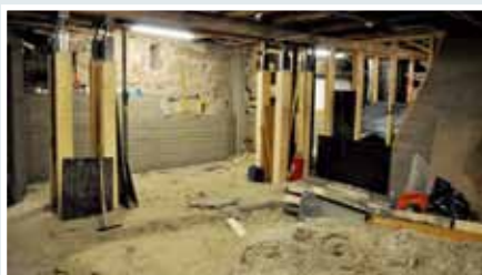
I oktober 2008 var kjellerrommet gravd ut, og arbeidet med utformingen satt i gang.
